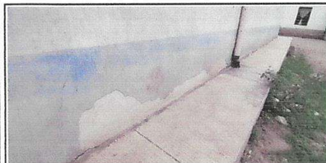
Foto 5: En varias áreas de las paredes se tiene desprendimiento del tallado por lo que es necesario resanar las paredes aplicando repello y cernido mas la pintura en las paredes que es evidente la necesidad.
