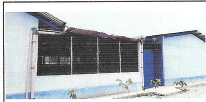
Foto 6: Esta área ya no presta seguridad pues lo que existe es malla galvanizada que fácilmente han deshilado por donde pueden ingresar personas sin autorización y sería mejor colocar baranda con barrotes.
